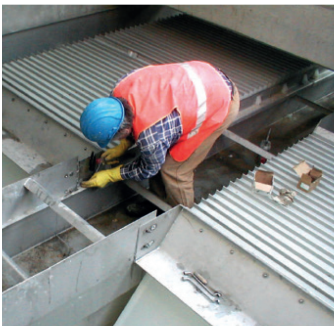
Einbau von Lamellenpaketen Installation of bundles of lamellas
